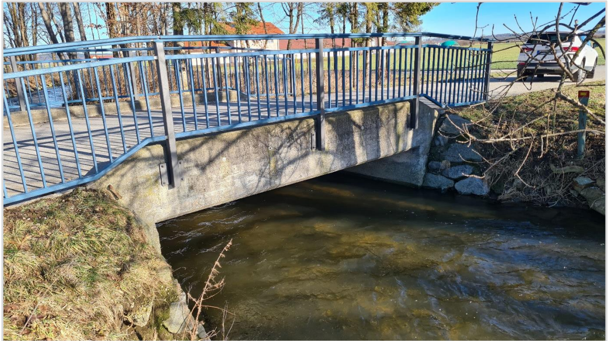
Abbildung 2: Brücke am Frauenweg
